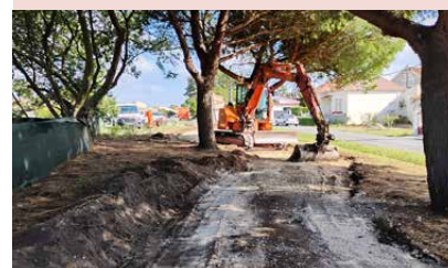
Les travaux à Bourcefranc l'été dernier.
