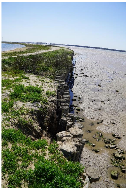
Figure 16 : Photographie des désordres en tête d'ouvrage la digue du bassin aquatique de Marennes-Plage, regard vers le Sud, avril 2025, GIP Littoral Martin Renard.
