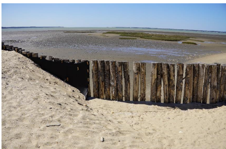
Figure 17 : Photographie du pieutage de la digue du bassin aquatique de Marennes-Plage, regard vers l'Ouest, avril 2025, GIP Littoral Martin Renard.
