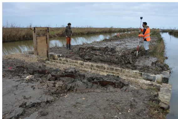
Réhabilitation d'un ouvrage hydraulique
