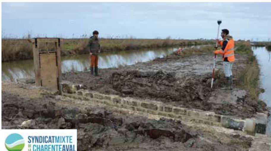
à l'aide d'une vis sans fin. Nouveauté : l'installation permet une gestion de l'eau par le fond, mais aussi par surverse grâce à des encoches qui peuvent accueillir un batardeau.
