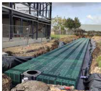
Bassin de rétention des eaux pluviales.
