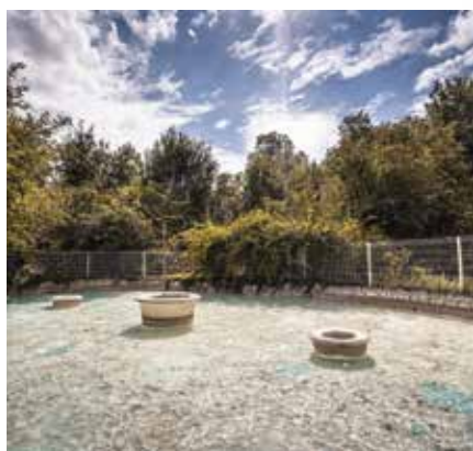
Station de captage d'eau.
