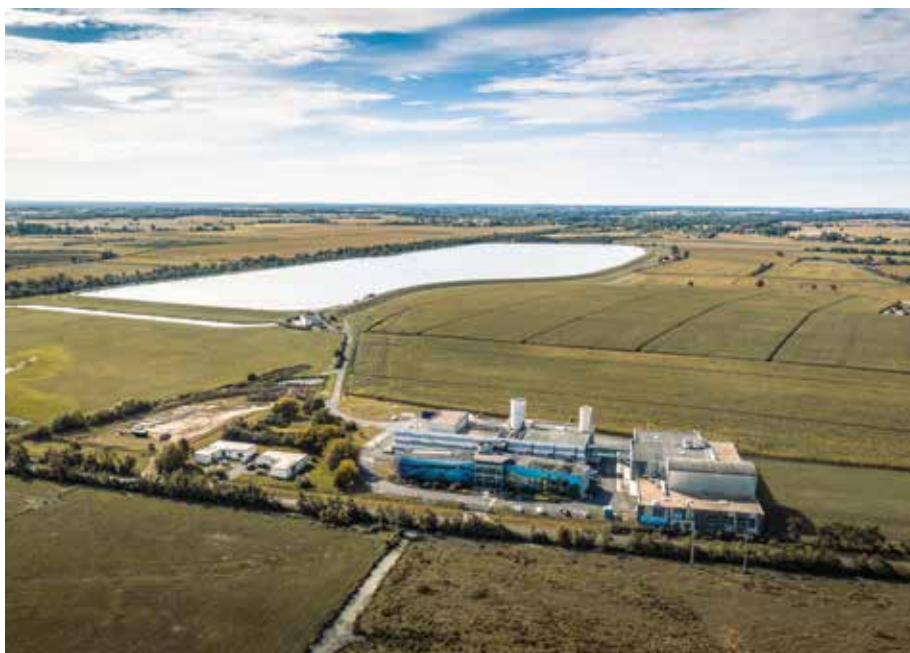
L'usine de production d'eau potable à Saint-Hippolyte, au sud-est de Rochefort.
