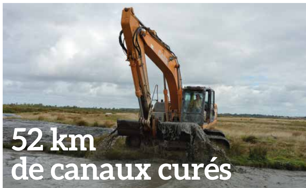
Des milliers de tonnes de vases ont été extraites des canaux à la pelleuseuse.
