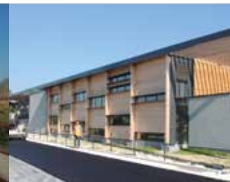
Livraison du bâtiment du dojo et du stade d'athlétisme à Marennes
