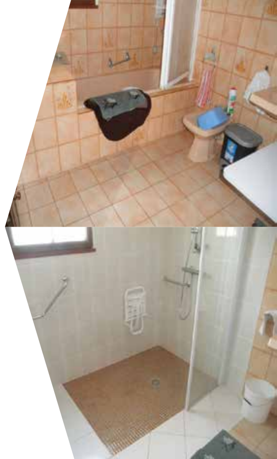
Adaptation de salle de bains : Travaux de plomberie et aménagement d'équipements sanitaires.
