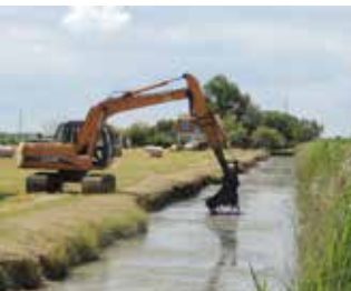
Réhabilitation du canal de Broue
