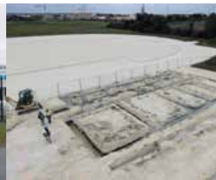
Construction d'un stade d'athlétisme et d'un dojo, deux équipements mutualisés en un seul et même endroit
